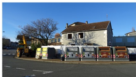
Destruction de la maison « SENAY » Avenue Louis Pasteur
